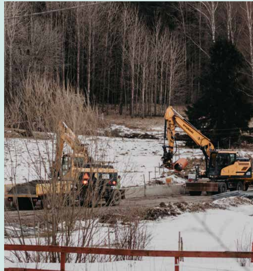
Roslagsvatten arbetar med anläggning av VA-system till Kristineberg 1 i Vallentuna.
